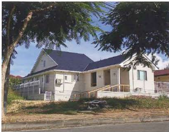
石垣島のツーバイフォーによる住宅建設の様子
