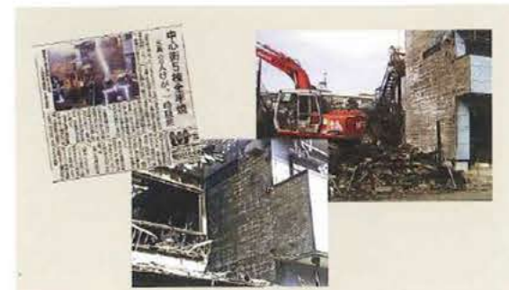
出火元住宅の解体後、姿を現したツーバイフォー住宅の西側の外壁。隣家との距離はわずか40cmであるにもかかわらず、表面の色がこげる程度の被害ですんでいる。（静岡県支部提供）
